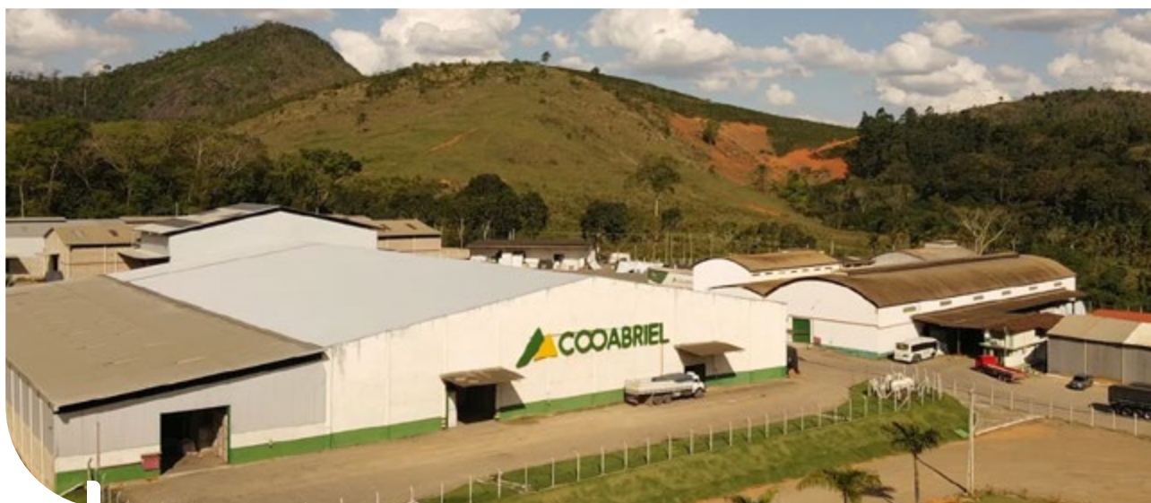
Complexo de armazéns da Coobrirel, em São Gabriel da Palha.
