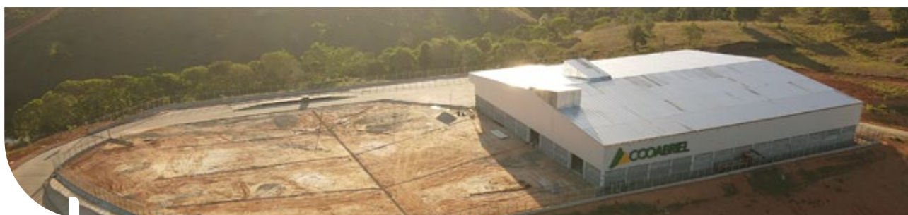
Unidade de armazenagem da Cooabriel na Bahia.
